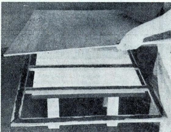
● **FATE I TELAII** per i sette pannelli tagliando a 45° le estremità dei correntini di 25x50 ed unendoli con colla, chiodi e fermagiunti corrugati od a cavaliere. Traversini extra sulle fiancate di 600x1800, fissate a 300 mm. dalla sommità, serviranno per sostenere il divisorio interno.
